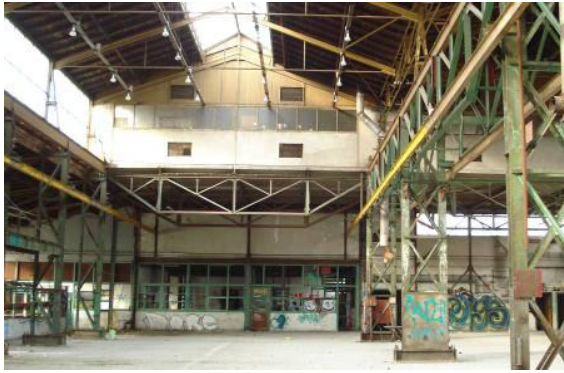
Afb.22 Zicht op de bijruimtes, het kantoor en magazijn vanuit de grote hal
