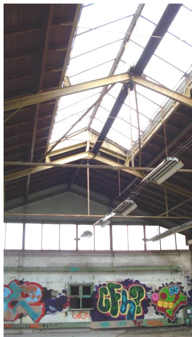
Afb.14 In de twee binnenste fabriekshallen zijn de daken voorzien van lichtstraten.
