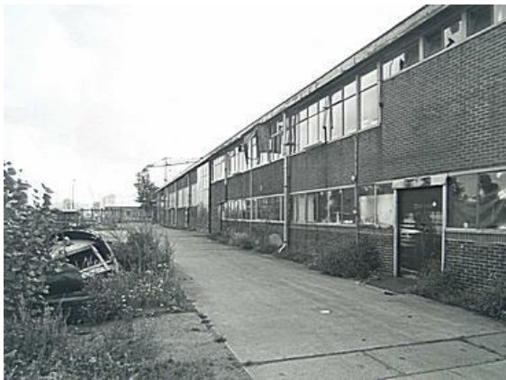
Afb. 31 De verlaten scheepswerf de Biesbosch aan de zijgevel. De werf ging in juli 2000 failliet (DiEP, 552_301292)
