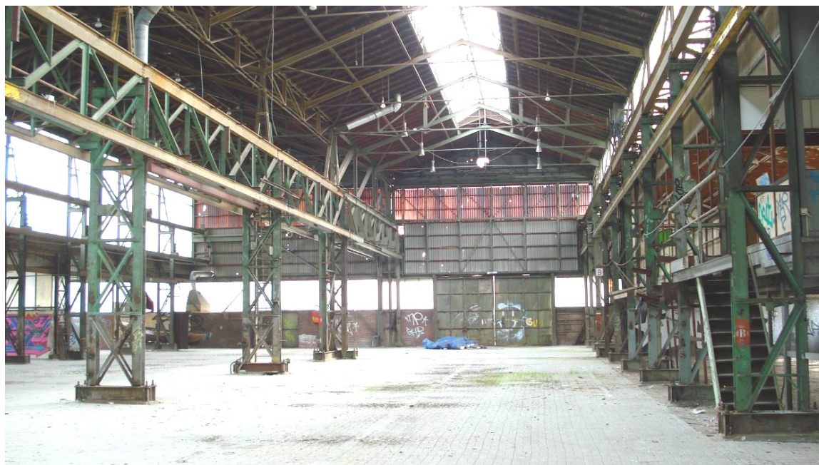
Afb.13 Zicht op de grote hal gezien naar de zuidgevel, met kraanbanen en de stalen deuren.
