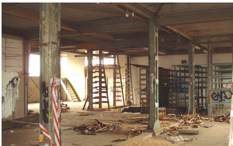
Afb.21 Ruimte onder het kantoor en magazijn
