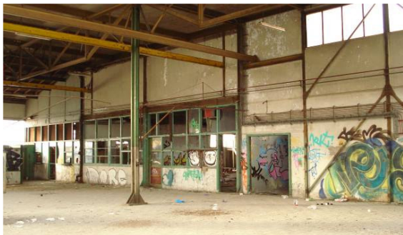
Afb.24 Zicht op de bijruimtes vanuit de grote hal. Rechts de doorgang naar de stalen trap.
