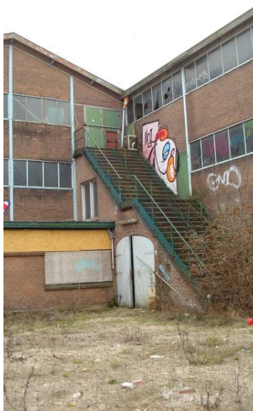
Afb.15 Stalen trap naar het bazenkantoor (directiekantoor) en het magazijn (noordzijde/ Maasstraat).
