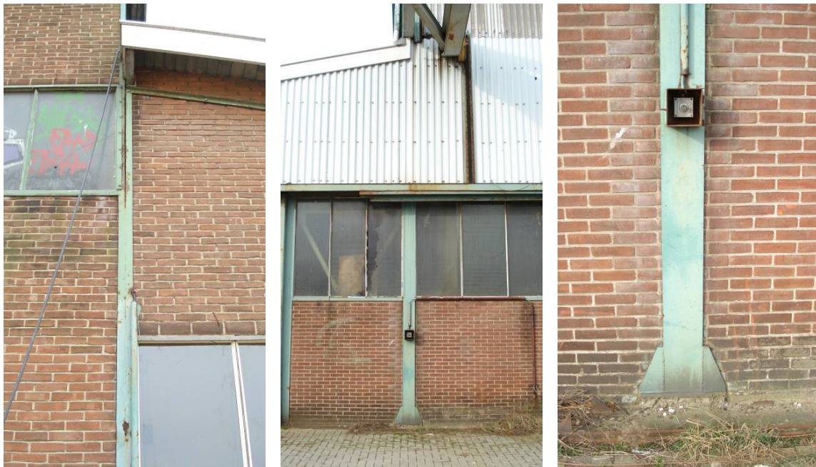
Afb. 10, 11, 12 Verticaal staalskelet, ingevuld met baksteen, draadglas en staalplaten.
