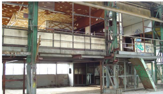
Afb.25 Zicht op de steiger en de opgang naar het zijvertrek op de verdieping.
