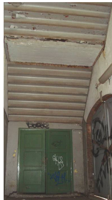
Afb.16 Kastruimte onder de stalen trap.
