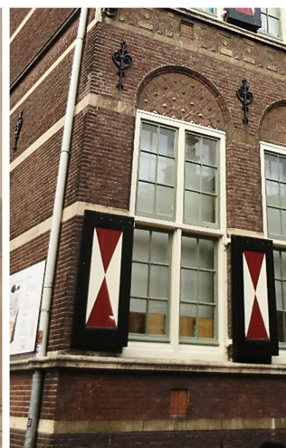
Detail van de gevel in 2014
