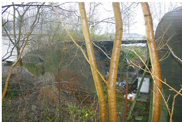
Vrijstaand gebouw voor waterberging ten oosten van bunker. Foto's 2004.
