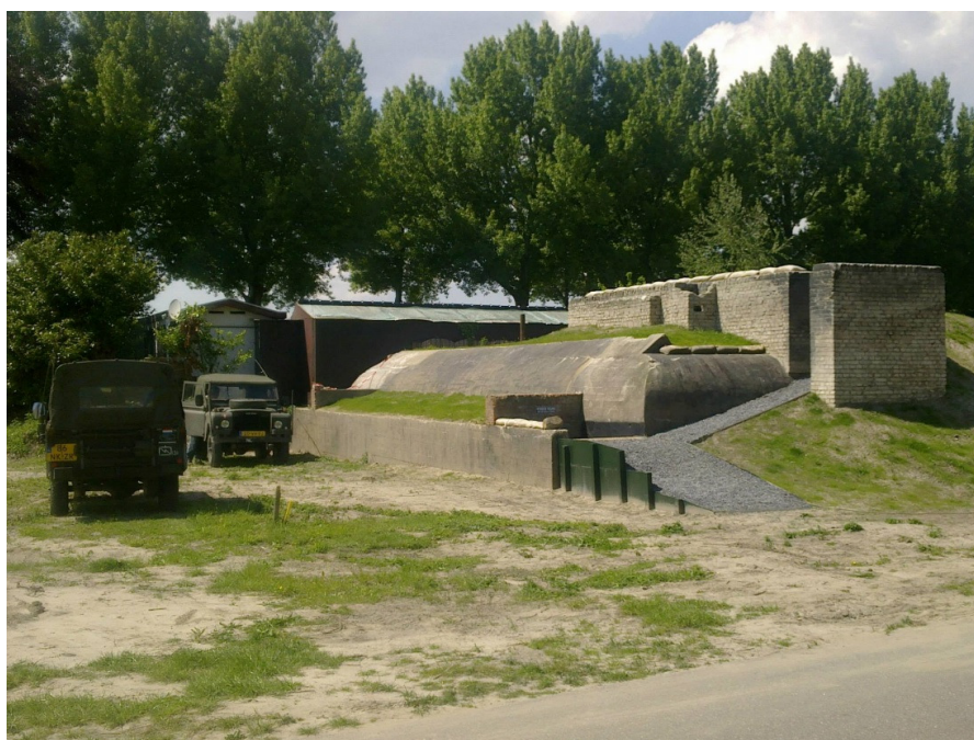
Bunker met op het dak een toegevoegde bakstenen FLAK-opstelling. Foto's 2014
