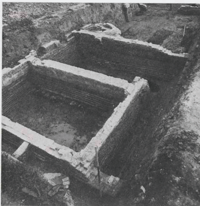
Afb. 25 Dordrecht. Woontoren gezien vanuit het zuidoosten. Binnen de grote en diep gefundeerde oorspronkelijke rechthoek is links een kleinere en gedeeltelijk hoger gefundeerde onderverdeling aangebracht. Op de pleisterlaag binnen deze laatste zijn twee vloerniveaus te onderscheiden. Bij het bovenste niveau behoort de later aangebouwde traptoren buiten de grote omtrek. Foto ROB.
