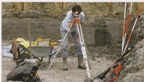
De verschillende grondlaagjes worden ingemeten met een waterpasinstrument
