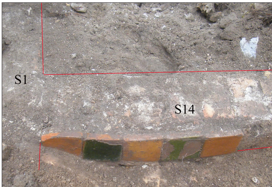
Afb. 26. Deel van de zijmuur van het lokaal van de Latijnse School uit de periode 18e-19e eeuw. Gezien op de aansluiting met de voorgevel in noordwestelijke richting.
