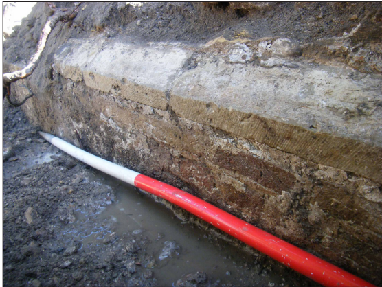
Afb. 17. Deel van de westelijke buitengevel van de kapel met een afgeschuinde plint van (kalk)zandsteen.
