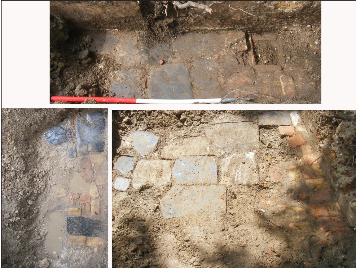
Afb. 31. Verschillende delen van een 17e –eeuwse verharding (S27) in de kapel. Op de bovenste foto is te zien dat de vloer tegen de binnenkant van de westgevel van de kapel loopt. Hier is ook een schrobputje (S47) in de vloer aanwezig. Maatstok = 1 m.
