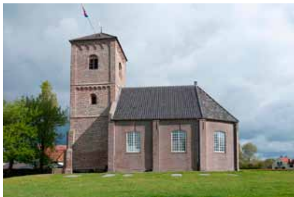
Afb. 269. De 'Stompe Toren', de rond 1225 in baksteen opgetrokken kerk van Spaarnwoude, gelegen op een strandwal (foto: K. Koomans).
