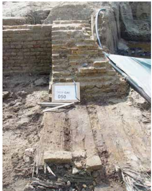
Afb. 45. De baksteenfundering van de middeleeuwse kerk staat direct op een laag planken van eikenhout.
