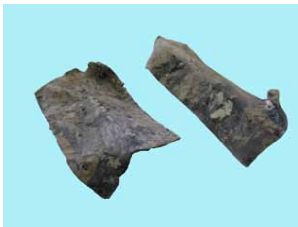
Afb. 58. Twee stukken gebogen lood die waarschijnlijk een functie in de dakbedekking hebben gehad.
