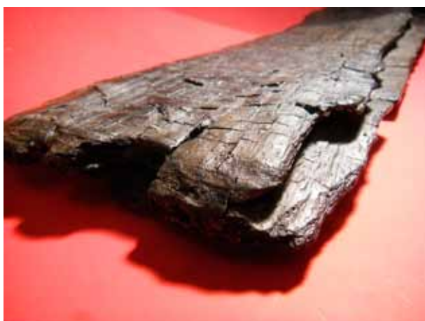
Afb. 54. De planken van het horizontale dakbeschot zijn onderling verbonden door een V-vormige gleuf aan de onderzijde, een zogenaamde vissenbek, en een V-vormige aanpunting aan de bovenzijde.
