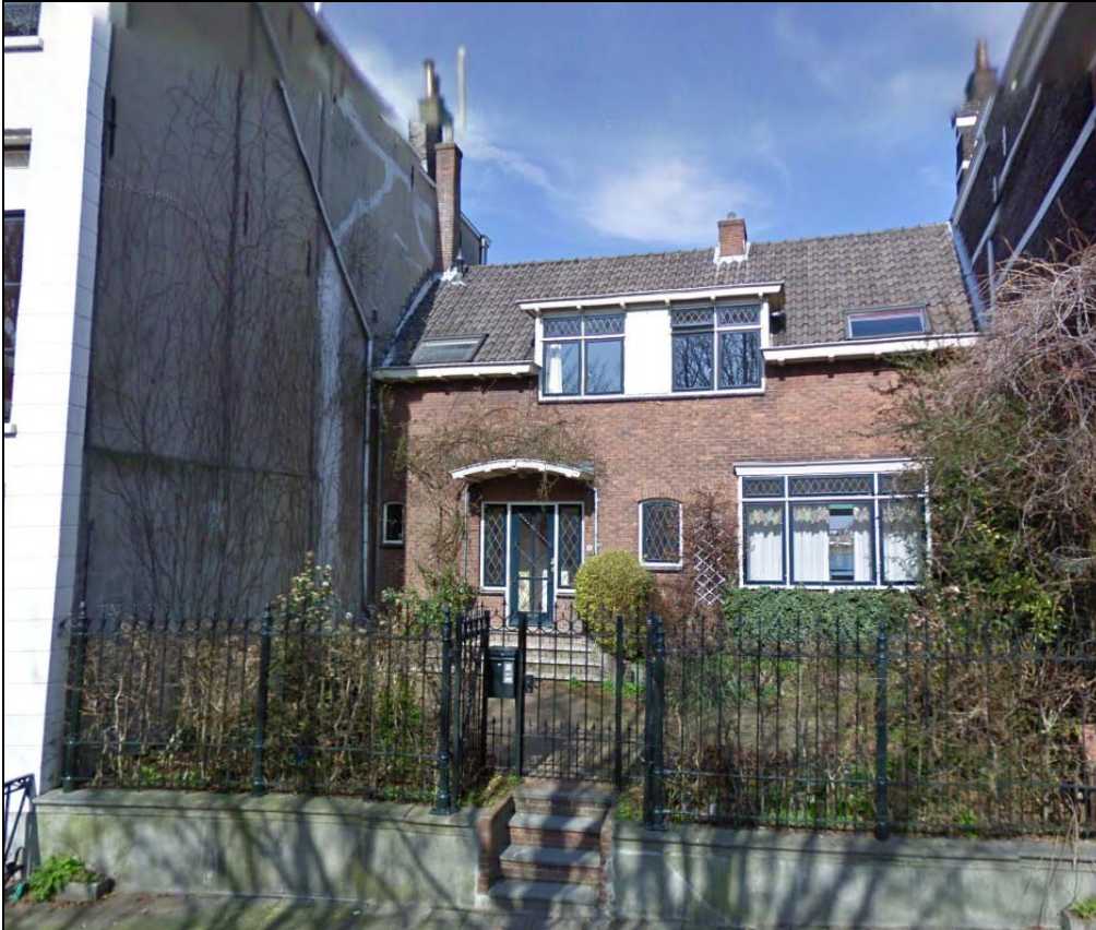
Afb. 2. Het plangebied Wolwevershaven 4 vóór de sloop van het huis uit 1954, gezien vanaf de Wolwevershaven.
