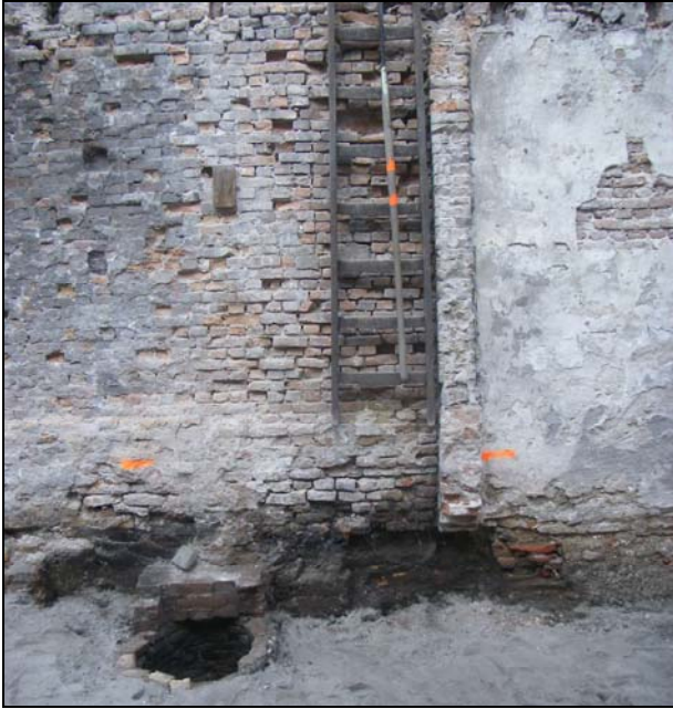
Afb. 13. Het waterputje op het open plaatsje achter de achtergevel van het pand Weeshuisplein 21 (middenrechts). De geplamuurde muur is het inpandige deel.
