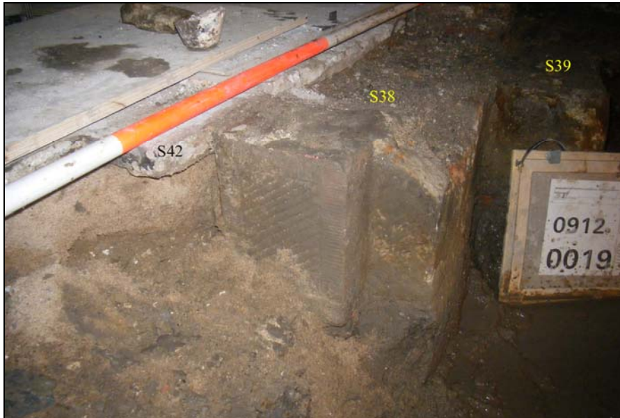
Afb. 13. De muur met doorgang en natuurstenen neut (S38). In de ruimte links is de (afgedekte) vloer van natuurstenen plavuizen te zien (S42).
