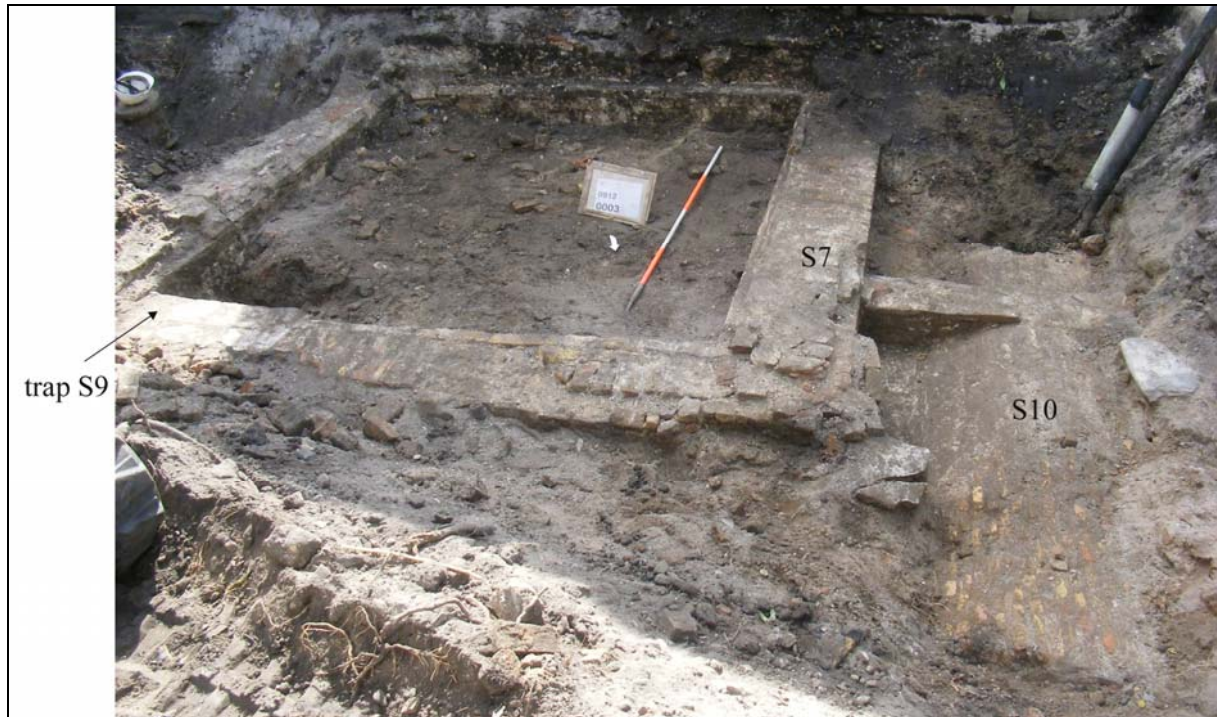
Afb. 10. De westelijke ruimte van de 17 e –eeuwse aanbouw op het achtererf van huis Roodenburch (S7). Links is de ingang met trap aanwezig (S9). Rechts is het tongewelf van de waterkelder S10 te zien. Fotorichting: zuid.
