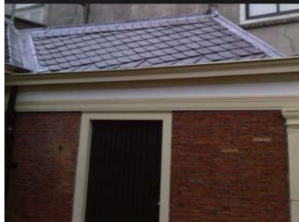
Afb. 37. Een foto van een leistein uit de 15 e -eeuwse beerkelder van pand 1, Mijns-herenherberg. Onder: een voorbeeld van een Rijnlandse dakdekking (de Vismarkt van Alkmaar).
