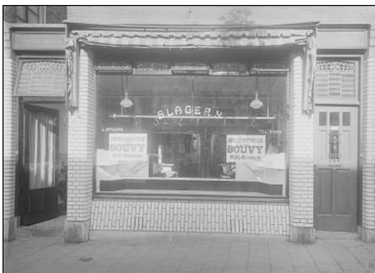
Afb. 9. Een foto van de gevel van het pand aan de Spuiweg 17 uit 1930. Links is de deur te zien dat toegang geeft tot de steeg en het achterterrein.
