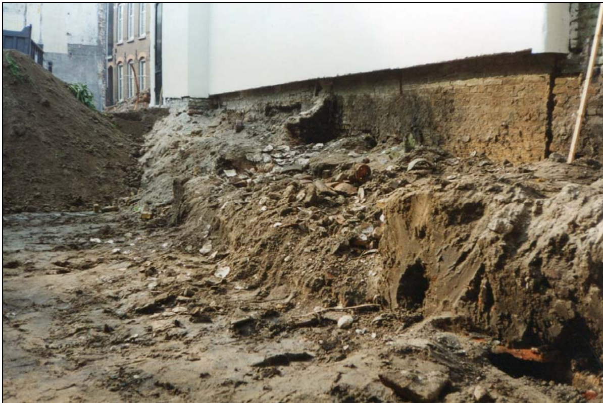
Afb. 8. De achtertuin en -gevel van de Schrijversstraat 7 op een foto die vermoedelijk genomen is na de ontgraving in het kader van de bodemsanering in 1996. Er zijn funderingsresten te zien, maar het is duidelijk dat er binnen 1 m – mv geen bebouwingsresten meer aanwezig zullen zijn. 5
