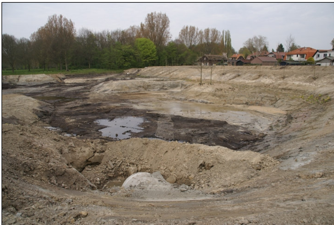
Afb. 12 Overzicht van de ontgravingen op het terrein De Vlaming, van zuid naar noord. Midden in beeld loopt van boven naar beneden en vrijwel exact noord-zuid een laatmiddeleeuwse sloot. De sloot is duidelijk in het veen ingegraven. Andere parallel lopende sloten zijn niet (meer) aanwezig.
