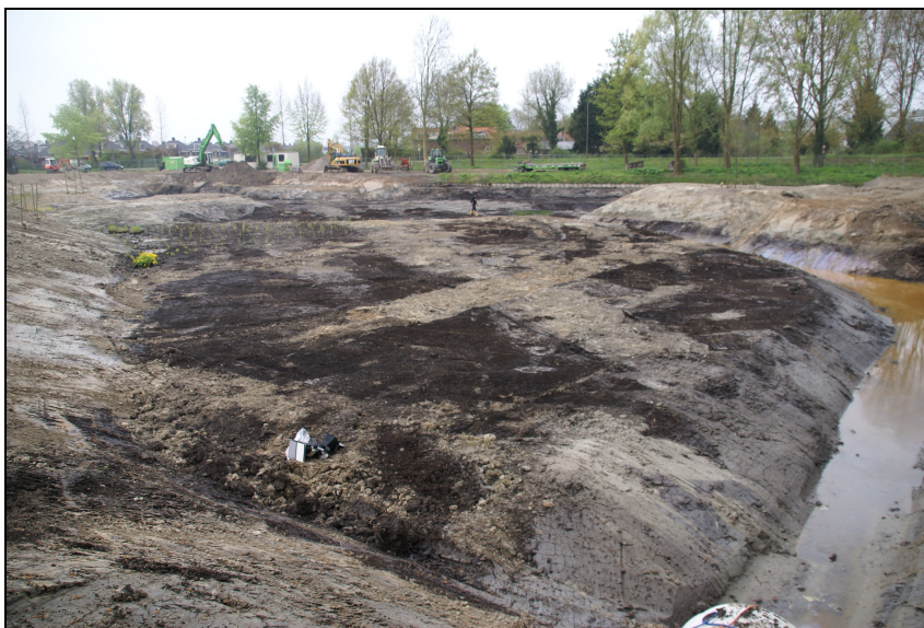
Overzicht van het terrein na de aanlegwerkzaamheden voor de ecozone (26 april 2010).
