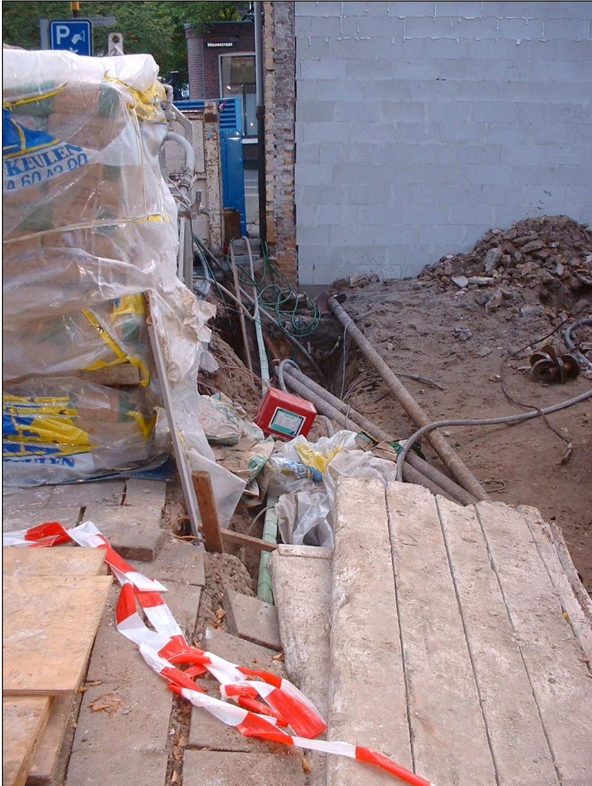
De achtergevel van Nieuwstraat nr.?? met een deels uitgebroken baksteenmuur: zie de berg stenen tegen de achtergevel.
