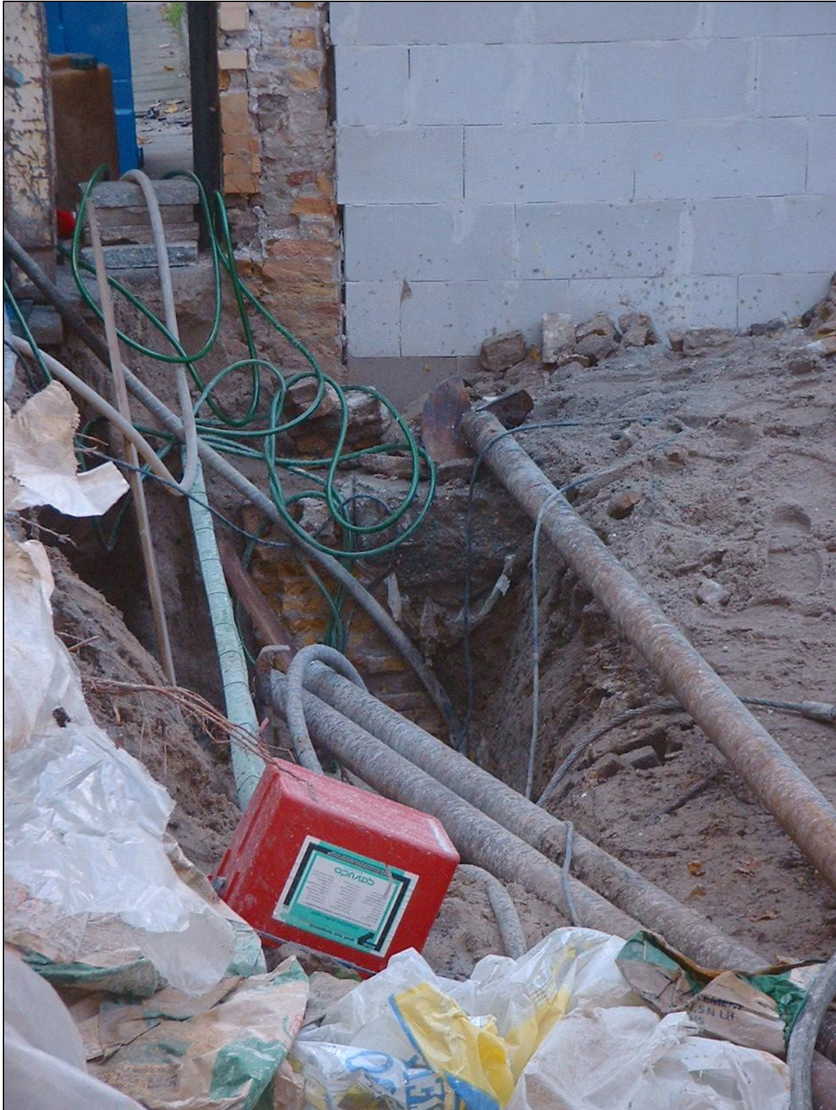
Detail van de uitgebroken muur.
