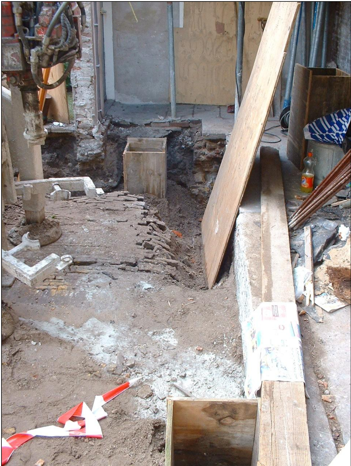
De hij- boorinstallatie staat op een vloer van IJsselsteentjes. De bekisting van twee palen is zichtbaar.
