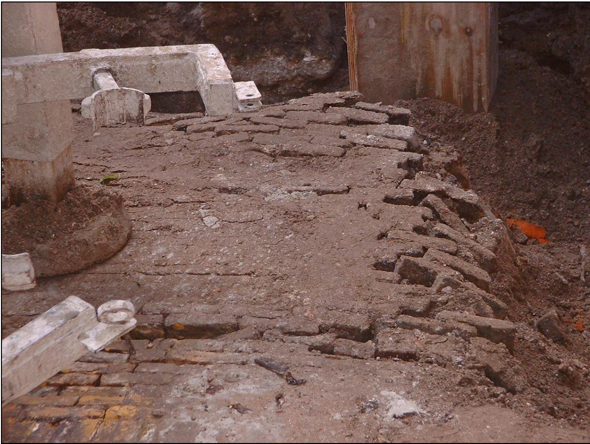
Detail van de nog aanwezige vloer van IJsselsteentjes.
