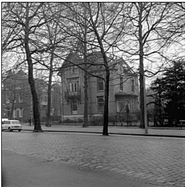
Afb. 7. Een foto uit 1962 van de kruising Johan de Wittstraat – Koningin Wilhelminastraat met daarop de leegstaande villa's in het plangebied.
