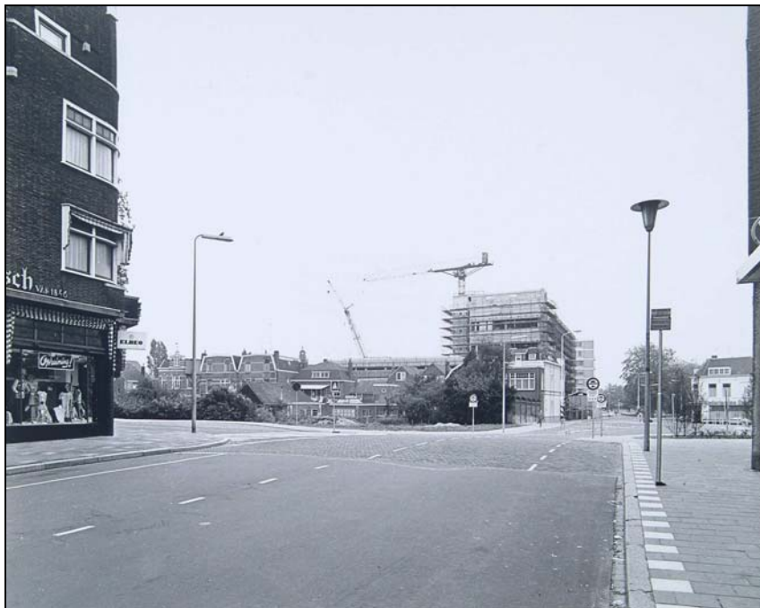
Foto uit 1975 van de bouw van het postkantoor in het plangebied aan de Johan de Wittstraat 120, gezien in zuidelijke richting vanaf de kruising met de Vest/Spuiboulevard (beeldbank DiEP, inventarisnr. 552_304704).
