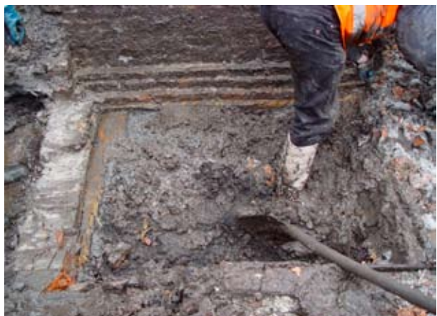
Afb. 28. 4-Laagse trapvormige fundering van structuur 1.
