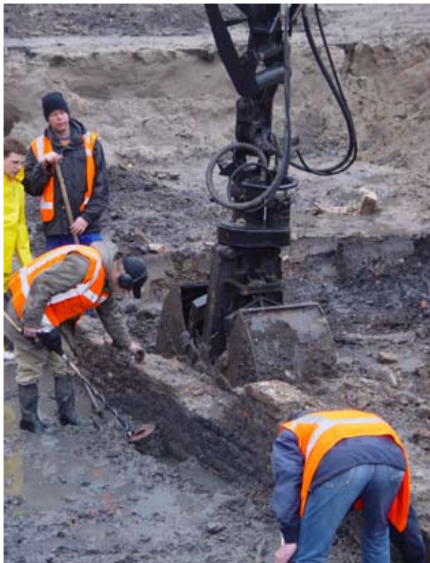
Afb. 13. Het gebruik van een knijpbak is handig voor het werken binnen (kleine) structuren.
