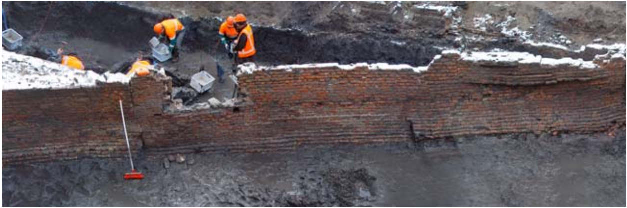
Afb. 33. Overzicht van het muurwerk.
