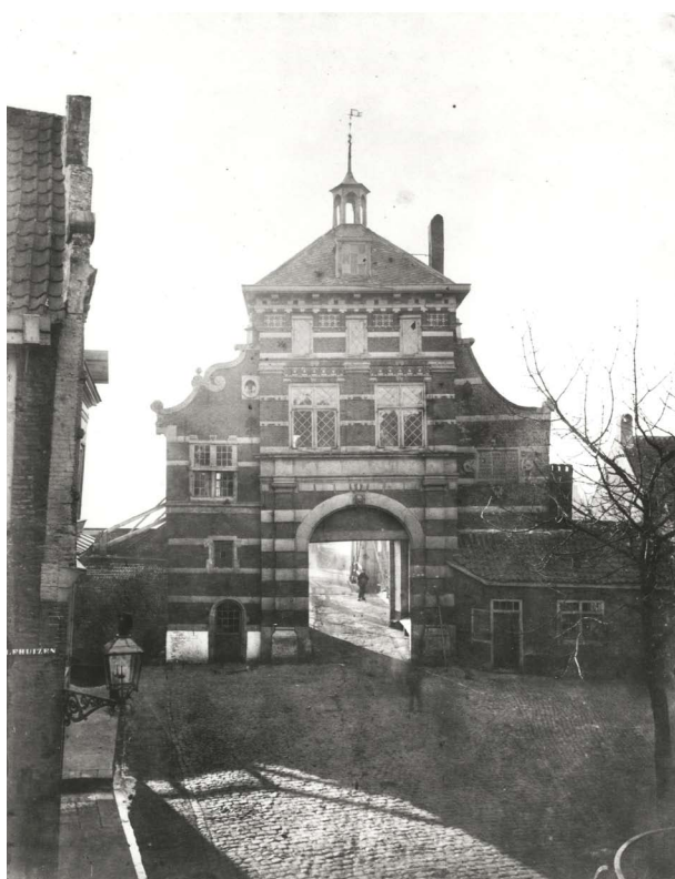
Afb. 9. De Spuiport vanuit de binnenzijde (Spuiplein) gezien.
