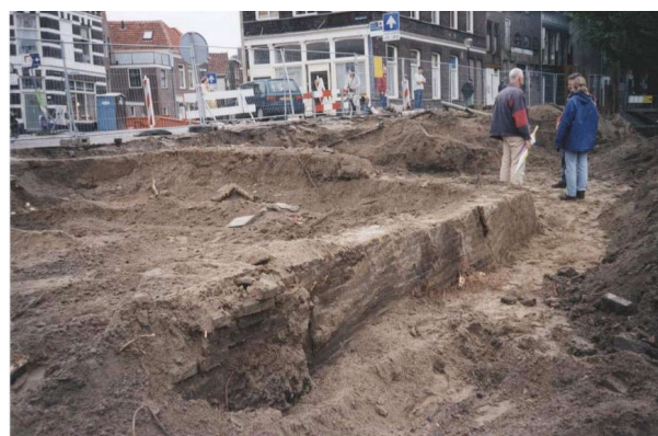
Afb. 21. Fundament van de Spui poort, met op de achtergrond het plangebied Elfhuizen.
