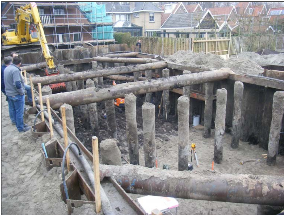
Een overzicht van de grootste bouwput in het plangebied tijdens het onderzoek.
