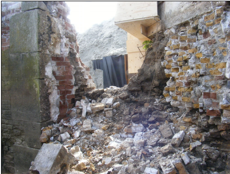
Afb. 11. De (kade) muur van het Damiatebolwerk gezien vanaf de Oude Maas met links het muurwerk uit 1910 en rechts het restant van een oudere, mogelijk 18 e -eeuwse, fase van het bolwerk.
