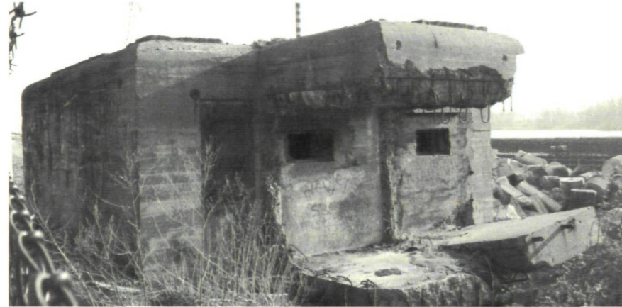
Eén van de bunkers uit 1936. Oorspronkelijk met de twee schietopeningen naar de rivier. Door de Duitsers gedraaid. Naar verluidt lange tijd in gebruik geweest bij de Hells Angels. Aan de voorzijde ligt ook nog een restant van een geschutskoepel (Tobruk).
