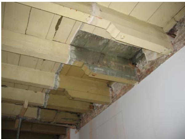
De rotte balkkoppen zijn verwijderd en aangegoten. Deze vloerconstructie is daarna achter een verlaagd plafond uit het zicht verdwenen.
