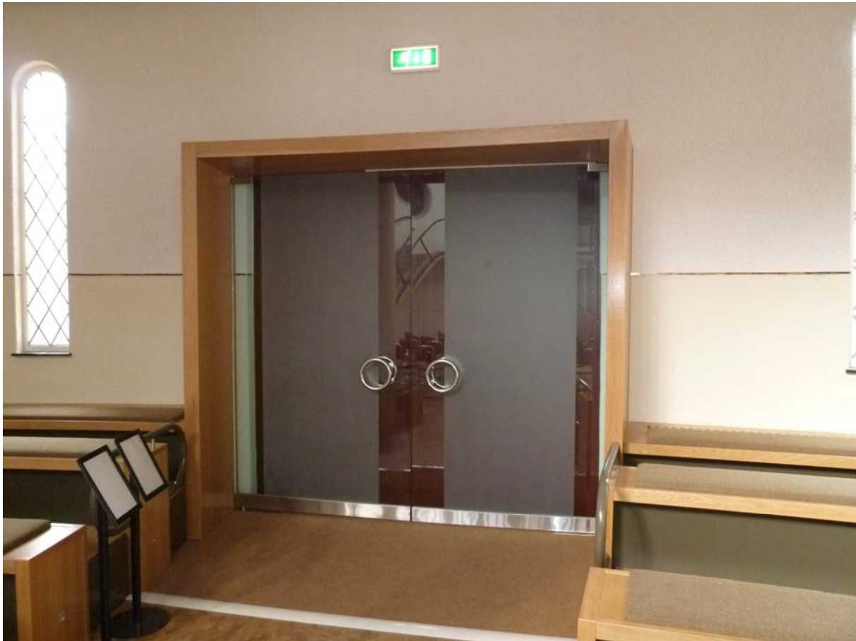
Hoofdingang met nieuwe binnendeuren
