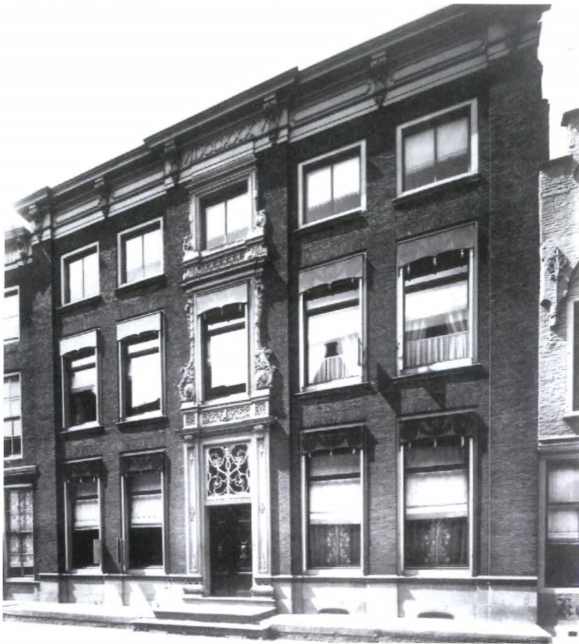
Het herenhuis Wijnstraat 51 (nu 87) kort na 1900. Rijksbetaalmeester J.C.van Hasselt, eigenaar van het huis van 1887 tot 1916, is verantwoordelijk voor enige 'modernisering'. Zo zijn onder meer de oude schuiframen vervangen door ramen zonder roedenverdeling. Stores (trekjalouzieën) voor de ramen temperen het invallende zonlicht. Foto: Collectie Boshoven, monumentenzorg Dordrecht.
