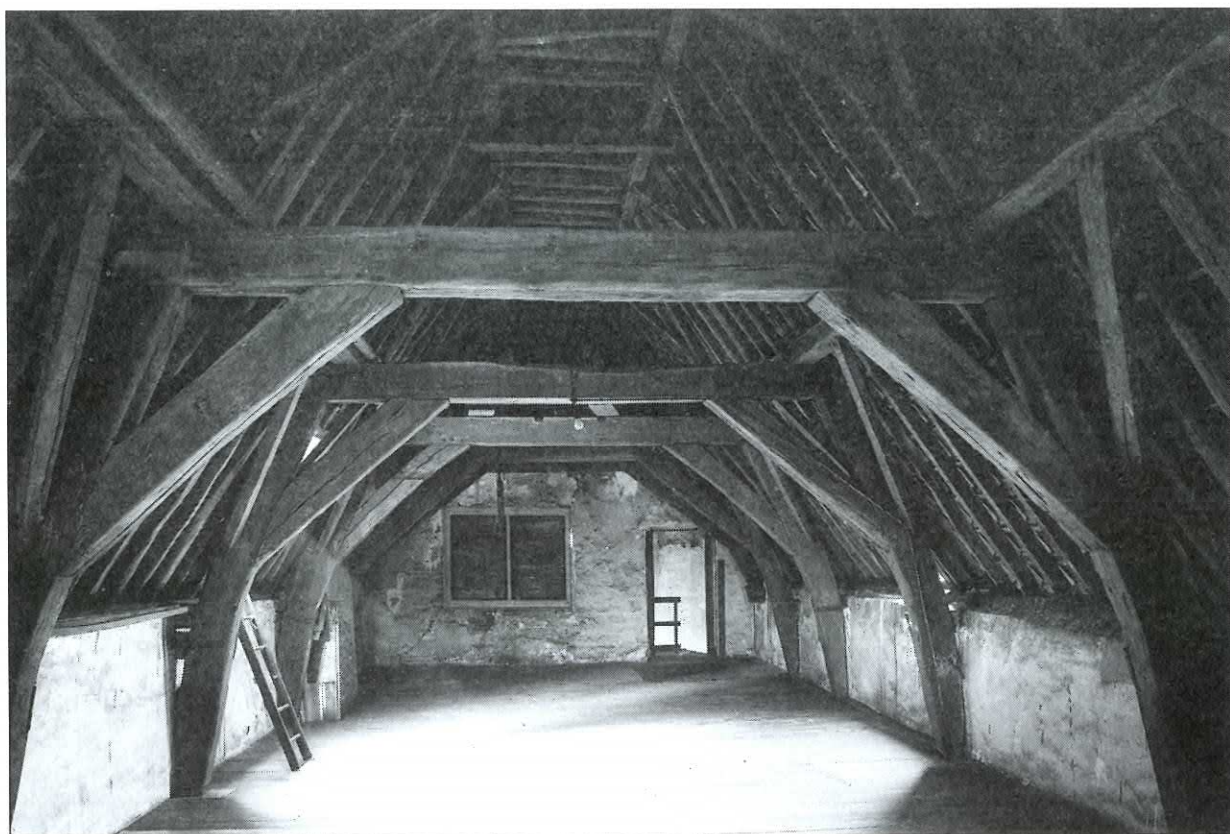
Aanwezige oorspronkelijke kapconstructie van Het Zeepaert uit circa 1490.
