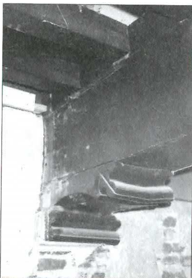
8. Het komt in de binnenstad nog regelmatig voor dat achter de zachtboard- of gipsplaten plafonds middeleeuwse vloerconstructies schuil gaan. Soms zijn de vaak fraai bewerkte sleutelstukken (stuk hout t.p.v. de oplegging onder vloerbalk) ook nog aanwezig. De foto toont een laat-middeleeuwse eiken vloer met zware moerbalk en een sleutelstuk hieronder met nog gotische profilering in de vorm van een peerkraal, zoals aanwezig in Voorstraat 182/184. Het dateert van ongeveer 1500. (Foto DSO/RB/MZ).
