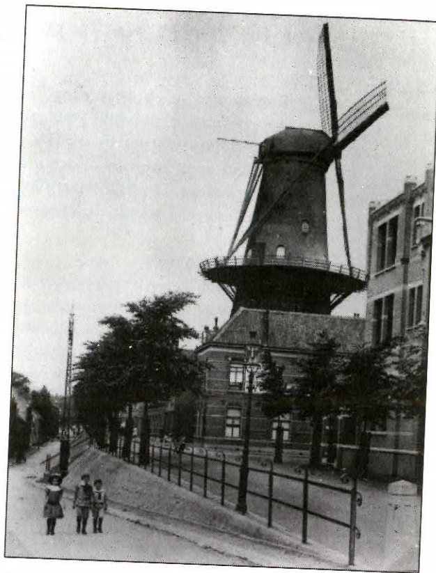
Boven: Afb 6 De Noordendijk met de stellingmolen 'Kijk over den Dijk' rond 1910. Deze scheefgezakte molen zal binnenkort worden rechtgezet. (Foto MZ)
