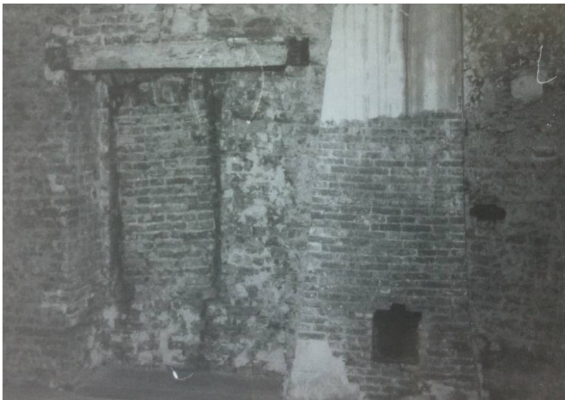
Afb. 23 Kuipershaven 38, zolder, zuidwestelijke bouwmuur. Links van het rookkanaal is een nis zichtbaar die duidelijk later is dichtgezet. Vermoedelijk gaat dit om een oorspronkelijke vensteropening. De zijanten lopen schuin naar binnen om zoveel mogelijk daglicht binnen te laten. Foto: collectie F.W. Retel
