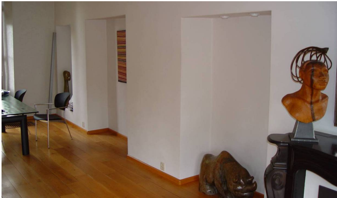
Afb. 21 Kuipershaven 38, 1 e verdieping. De drie linker nissen in de rechter bouwmuur. De eerste en derde eindigen op ongeveer gelijke hoogte. Onder de 1 e zit een lage borstwering.
