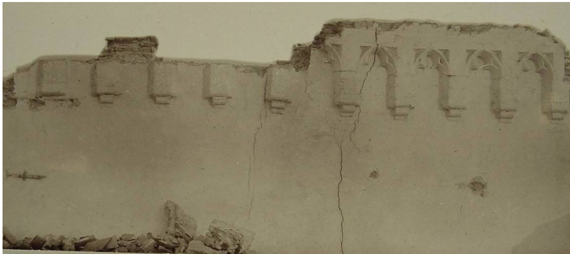
Afb. 10 Foto uit 1903 van de blootgelegde zuidwestelijke buitenmuur van de Alaerd van Wijngaerdentoren of Drenckwaertstoren . Gezien richting het oosten. Geheel links is een muuranker zichtbaar. Aan de onderzijde is puin zichtbaar van de al gedeeltelijk afgebroken muur. (RAD 551_50108)
