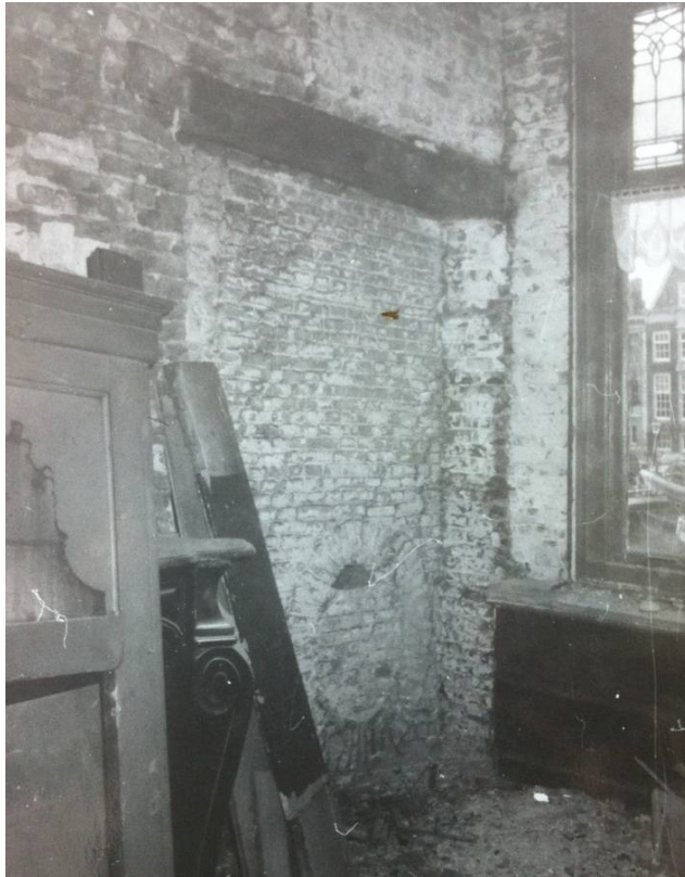
Afb. 22 Kuipershaven 38, 1 e verdieping. De meest rechter nis in de zuidwestelijke bouwmuur rond 1990. Bij een verbouwing was deze ontleisterd en was een dichtgemetseld ovaal venster zichtbaar aan de onderzijde. Het metselwerk boven de houten balk is deels middeleeuws, en deels recentier. Vermoedelijk is deze constructie in 1840 aangebracht om de voorgevel te koppelen aan de zijgevel. Mogelijk was de nis in gebruik als ondiepe kast. Rechts lijken sporen van plankdragers zichtbaar te zijn. Foto: collectie F.W. Retel
