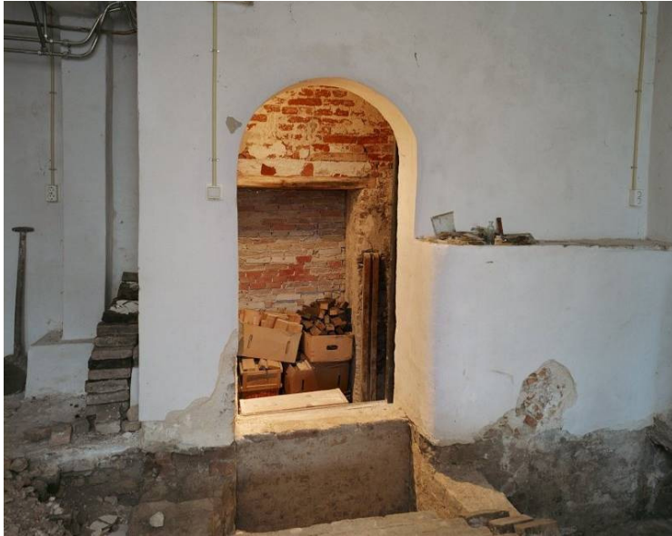
Afb. 16 Kuipershaven 38, begane grond gezien richting de achtergevel. Rechts achterin is een kleine ruimte afgescheiden. In de ruimte is een dichtgezette doorgang zichtbaar naar de tuin die in 1903. Deze doorgang was in 1903 nog open en is kort na deze foto weer geopend. RCE 501.388
