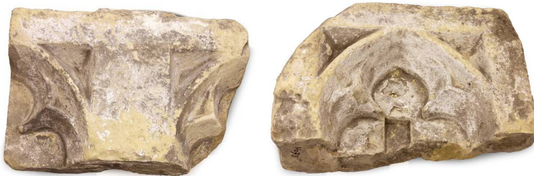
Afb. 12 Objecten M283-003 en M283-006 uit het bouwhistorisch depot van de gemeente Dordrecht. Naast deze twee grotere stukken zijn er vier kleinere, halve bogen bewaard gebleven. M283-003 is herkenbaar op de foto uit 1903, links naast de scheur (afb. 6). Op de objecten zijn sporen van witkalk zichtbaar, zoals beschreven in het artikel van J.C. Overvoorde.
