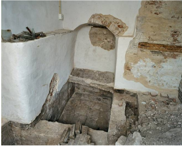
Afb. 18 Kuipershaven 38, begane grond. Gezien richting de rechter bouwmuur. Aan de linkerzijde is de scheidingsmuur met het kamertje rechtsachter te zien. RCE 501.387
