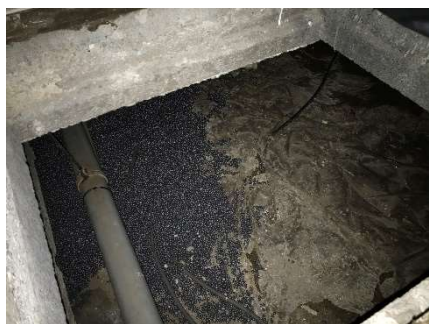
Kruipruimte, redelijk bereikbaar en droog
