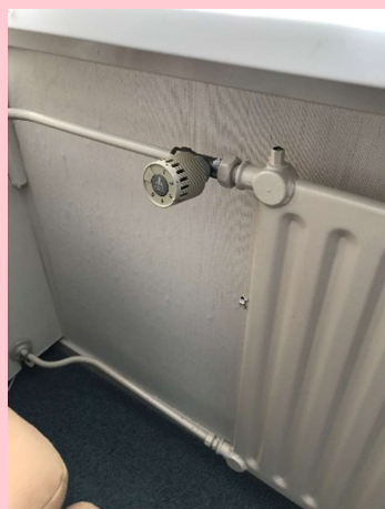
Verouderde radiatorkranen (niet dubbel instelbaar) en enkele leden radiatoren op 1 e etage (check capaciteit)
