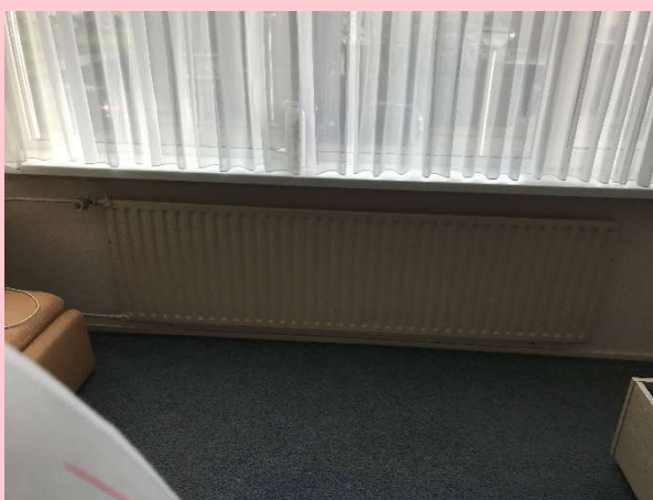
Verouderde radiatorkranen (niet dubbel instelbaar) en enkele leden radiatoren op 1 e etage (check capaciteit)
