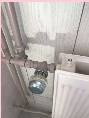
Verouderde radiatorkranen (niet dubbel instelbaar) en enkele leden radiatoren
