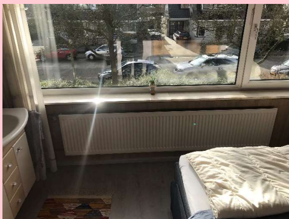
Verouderde radiatorkranen (niet dubbel instelbaar) en enkele leden radiatoren
