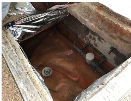
Kruipruimte begaanbaar, echter voorzien van Tonzonfolie (voorzichtig verwijderen)
