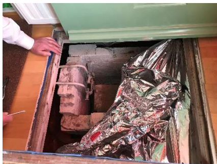
Meterkast (geen ruimte voor afleverset en beperkt toegankelijke kruipruimte voor invoer bij voordeur)
