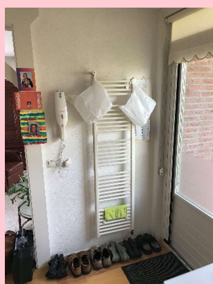
Aluminium radiatoren (i.v.m. dubbel gescheiden sets HVC waarschijnlijk geen probleem meer)
