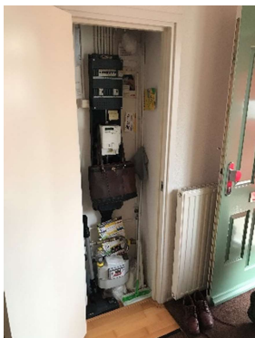
Meterkast (geen ruimte voor afleverset en beperkt toegankelijke kruipruimte voor invoer bij voordeur)
