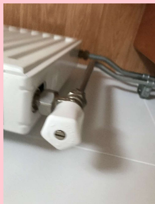
Open-dichtkranen radiatoren (niet dubbel instelbaar/inregelbaar)
