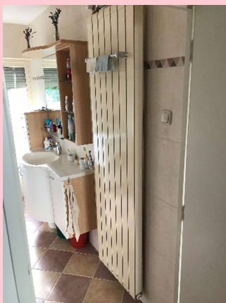
Aluminium radiatoren (i.v.m. dubbel gescheiden sets HVC waarschijnlijk geen probleem meer)
